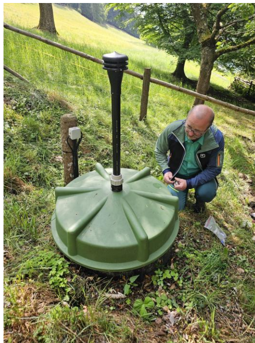
Abb. 3i: Zmöllach 12A – Moderne PE-Quellfassung mit Datenlogger und Leitungsanschluss. Im Hintergrund die typische Hangwiese mit direktem Anschluss an den bewaldeten Einzugsang. Feldaufnahme 31. Mai 2026.
